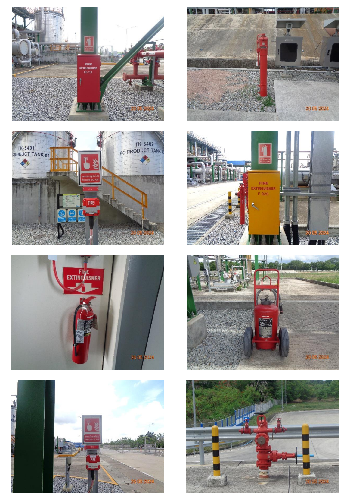
รูปที่ 3.48 อุปกรณ์ป้องกันและระงับอัคคีภัย (ต่อ)
