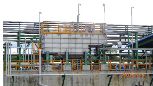
บ่อแยกน้ำมันและของแข็งแขวนลอย (Oil Separation/Suspended Solid Separation)
