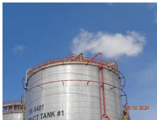
รูปที่ 3.42 ระบบน้ำฉีด (Water Spray) รอบผนังและหลังคาถังเก็บกัก
