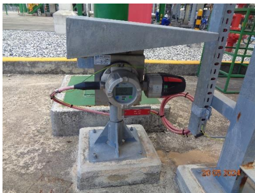
รูปที่ 3.56 ระบบตรวจจับ (Detector)
