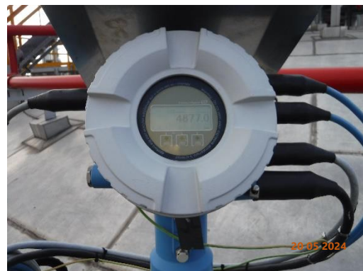
รูปที่ 3.61 อุปกรณ์วัดอุณหภูมิ และระดับของเหลว ในถังเก็บโพธิ์หินออกไซด์
