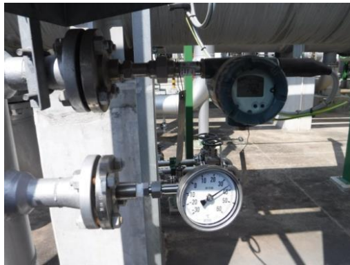
รูปที่ 3.55 Pressure / Temperature Indicator
