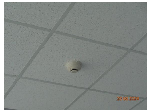
รูปที่ 3.56 ระบบตรวจจับ (Detector)
