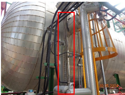
รูปที่ 3.52 Level Indicator ที่ถังเก็บกัก
